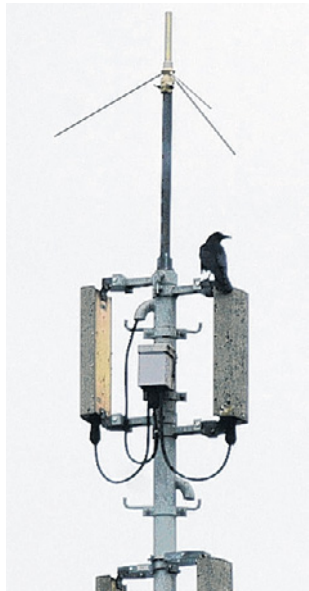
In Gebenstorf wird eine neue Antenne gebaut.
